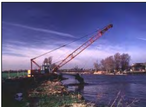
Figuur 9.3 Het mechanisch schonen van sloten veroorzaakt hoge sterfte bij inheemse mosselen.
